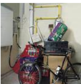
So kann sie aussehen... oder so: Hauptabsperreinrichtung am Hausanschluss
