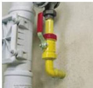
So kann sie aussehen... oder so: Hauptabsperreinrichtung am Hausanschluss
